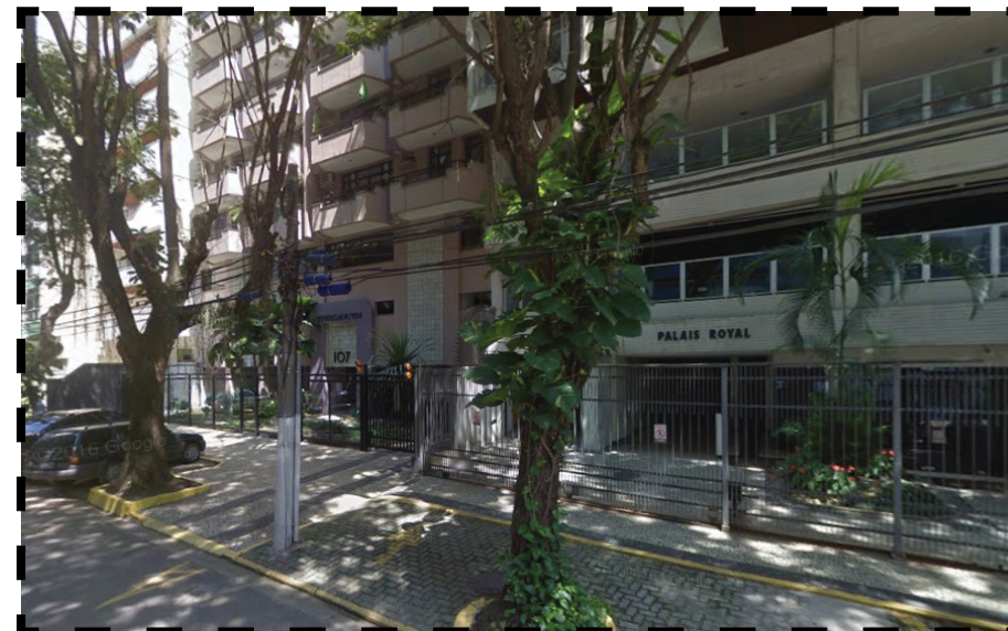
Edifícios residenciais – Rua Pereira Nunes Fonte: Google Earth.
