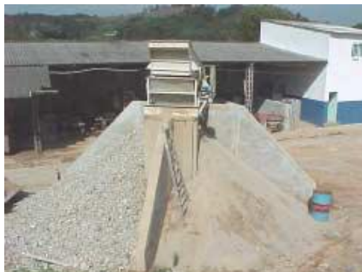
Figura 19: Equipamento da usina: peneirador mecânico acima das baias dos agregados.
