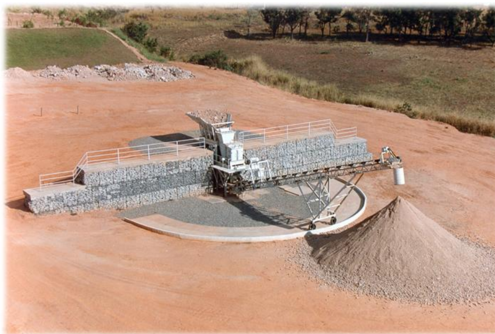
Figura 16: Estação de reciclagem, de Estoril – MG (Prefeitura BH)
