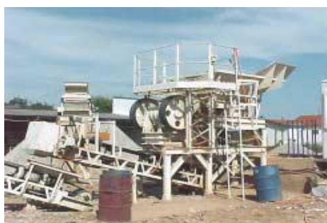
Figura 20: Equipamento da usina: conjunto alimentador vibratório +britador de mandíbulas + correia transportadora
