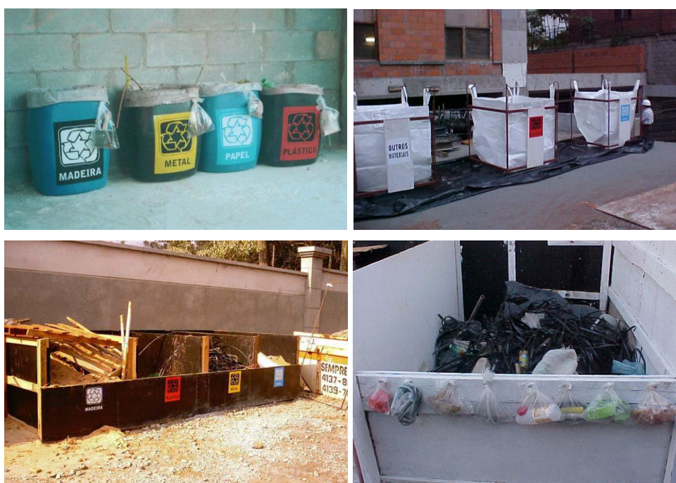
Figura 12: Segregação de resíduos no canteiro de obras.
