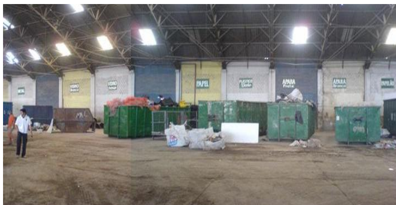
Figura 23 : Vista do fundo do galpão com as caçambas posicionadas para o recebimento dos resíduos conforme especificação existente na parede.
