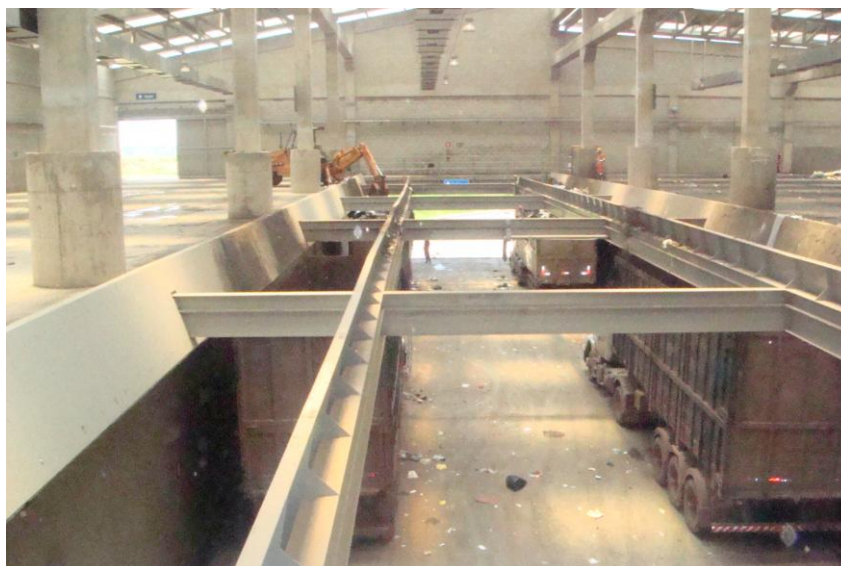
Figura 3 - Estação de Tratamento e Triagem 2
