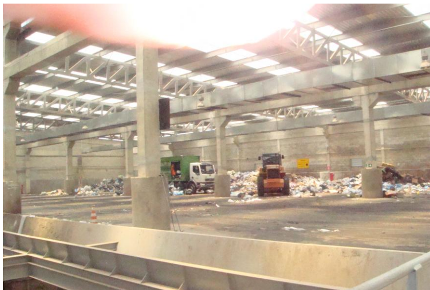
Figura 2 - Estação de Tratamento e Triagem 1
